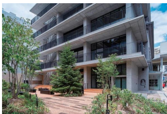
図 本通地区の取組事例(提供:アンデルセングループ)
